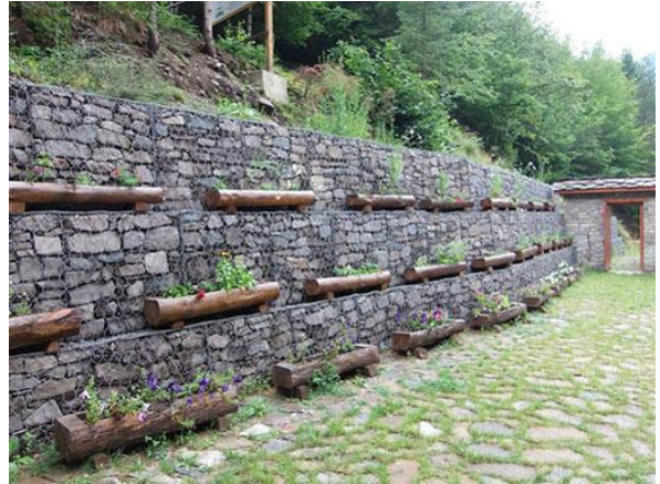
Figura 1. Estructura con gaviones. Fuente:
